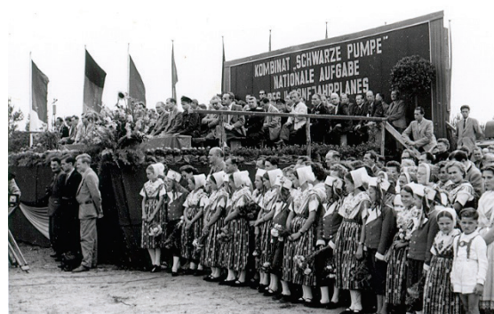
Abb. 1 – Baubeginn des Kombinats Schwarze Pumpe 1955
